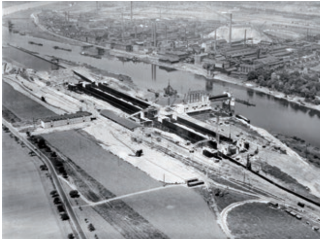
Infrastruktur: Staustufe im Bau, ca. 1926. (Foto: ISG)
