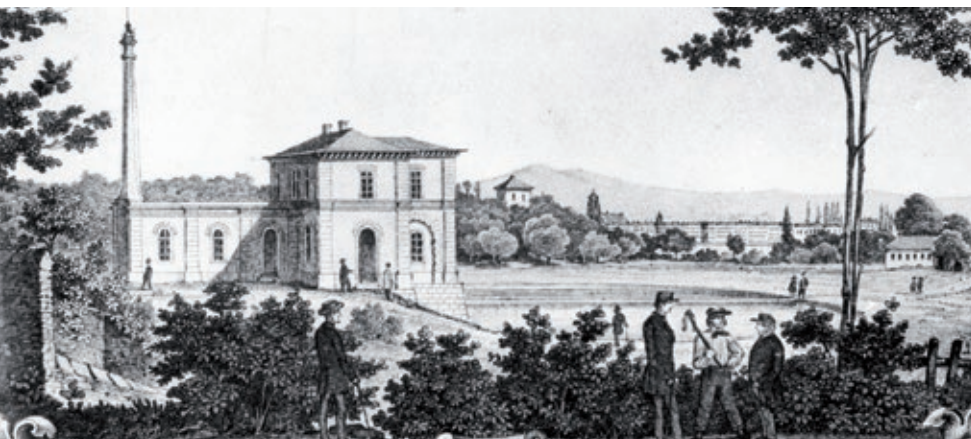
Neue Wasserleitung Frankfurt am Main, 1859. (Bild: ISG)
