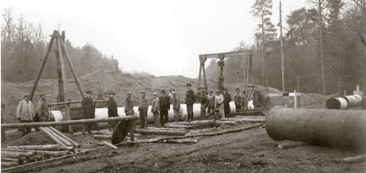
Bau eines Wasserwerks, 1934. (Foto: ISG)
